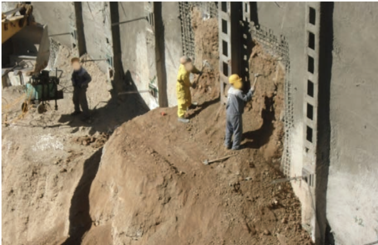
شکل ۲ رگلاژ دستی دیواره‌ی گود پس از خاکبرداری
