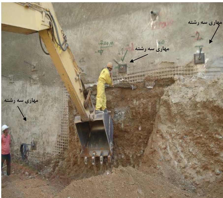
شکل ۱ پس از اجرای شاتکریت و اجرای مهاریهای ۲ بال و سمت چپ اقدام به پنل برداری شده است.
