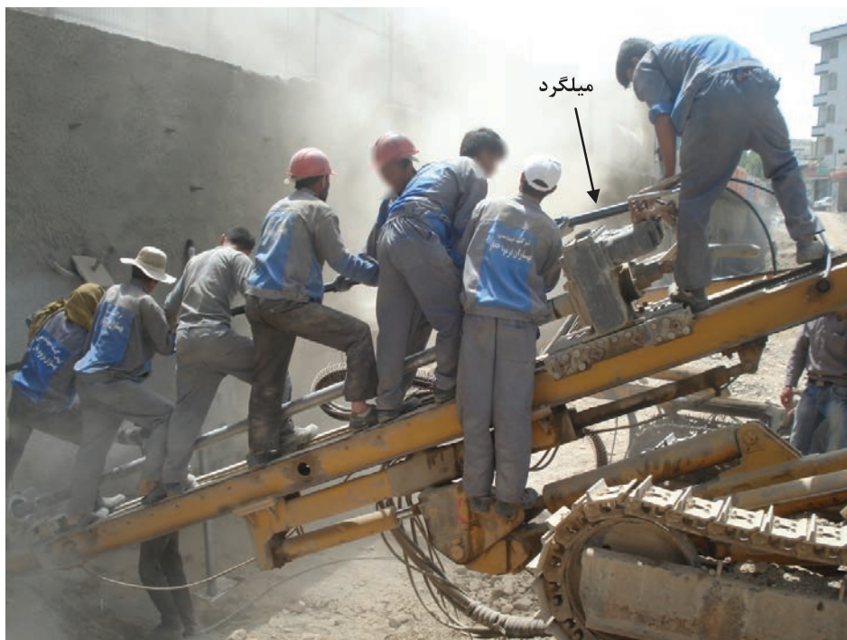
شکل ۶ کاشت میلگرد درون گمانه. دیده می‌شود کارگران به منظور تسلط بیشتر برای کاشت میلگرد به بالای دکل ماشین حفار رفته‌اند.
