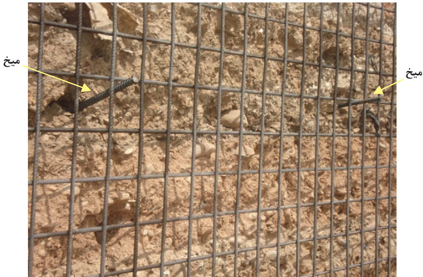
شکل ۳ میخ‌هانش تکیه‌گاه را برای نصب مش ایفا می‌کنند. سپس ورق مش نصب می‌شود. در شکل، یک مش ۸ میلی‌متر با چشمه‌های ۱۰ در ۱۰ سانتی‌متر دیده می‌شود.
