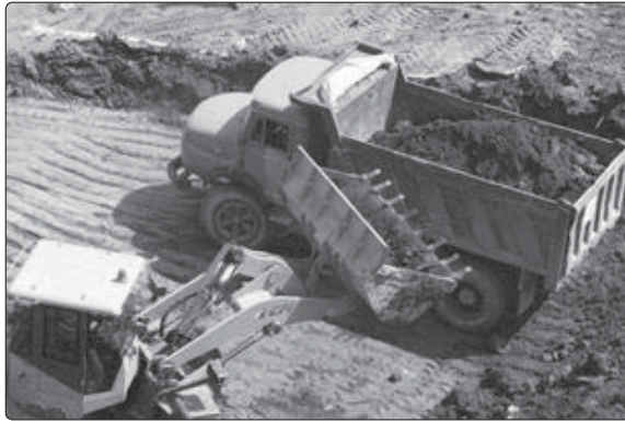
شکل ۶-۸ بارگیری و حمل خاک با کامیون
